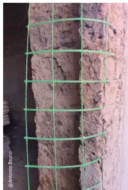
Figura 3 - Intonaco termico a spessore
