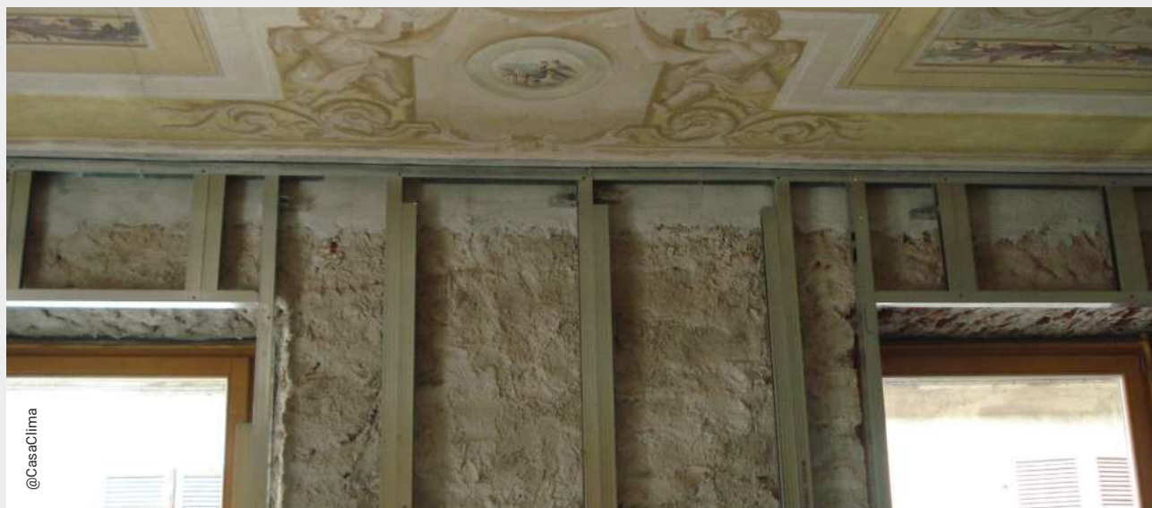
Foto 6 - Ristrutturazione con isolamento dall'interno delle pareti
